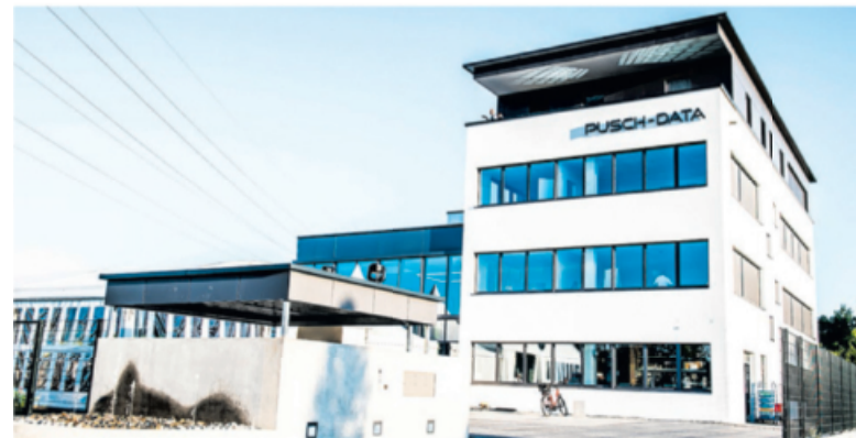
Vier Millionen Euro hat das IT-Unternehmen Pusch-Data in seinen Neubau in Eisingen investiert. Foto: Pusch Data
