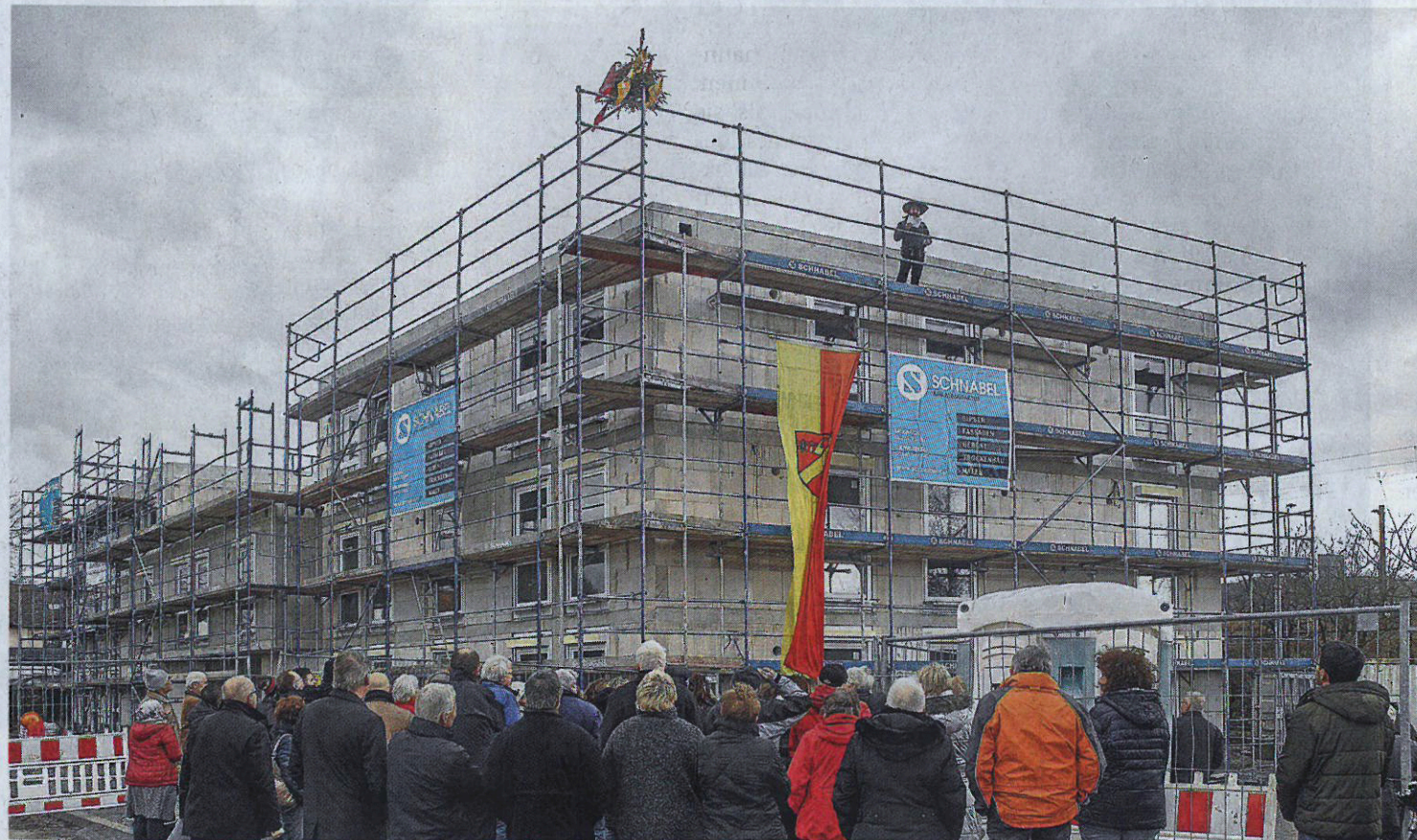
Richtfest an der neuen Flüchtlingsunterkunft in Tamm. Ende Juli soll das Haus bezugsfertig sein.
