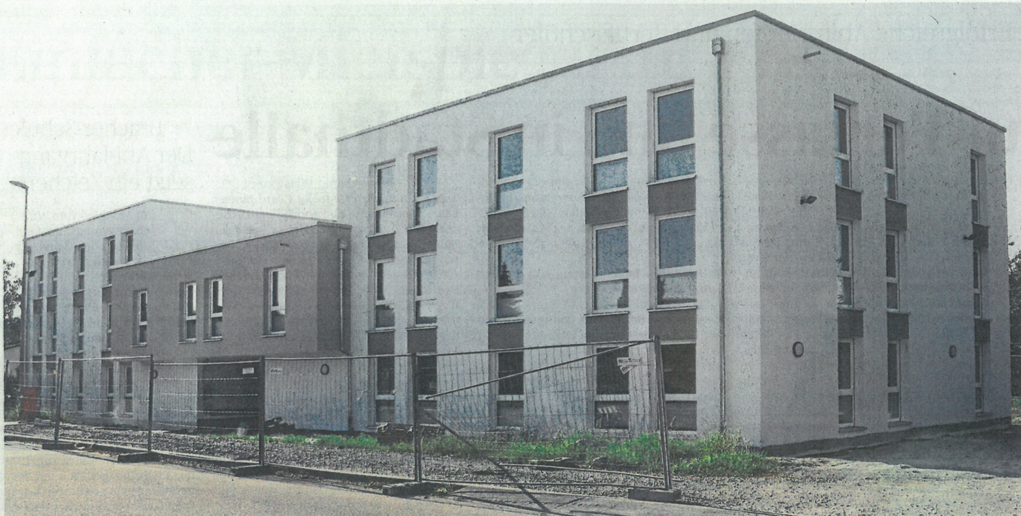
Demnächst beziehbar ist die neue Flüchtlingsunterkunft an der Ludwigsburger Straße. Vorbildlich: Das Gebäude hat „Niedrigstenergie-Niveau“.
